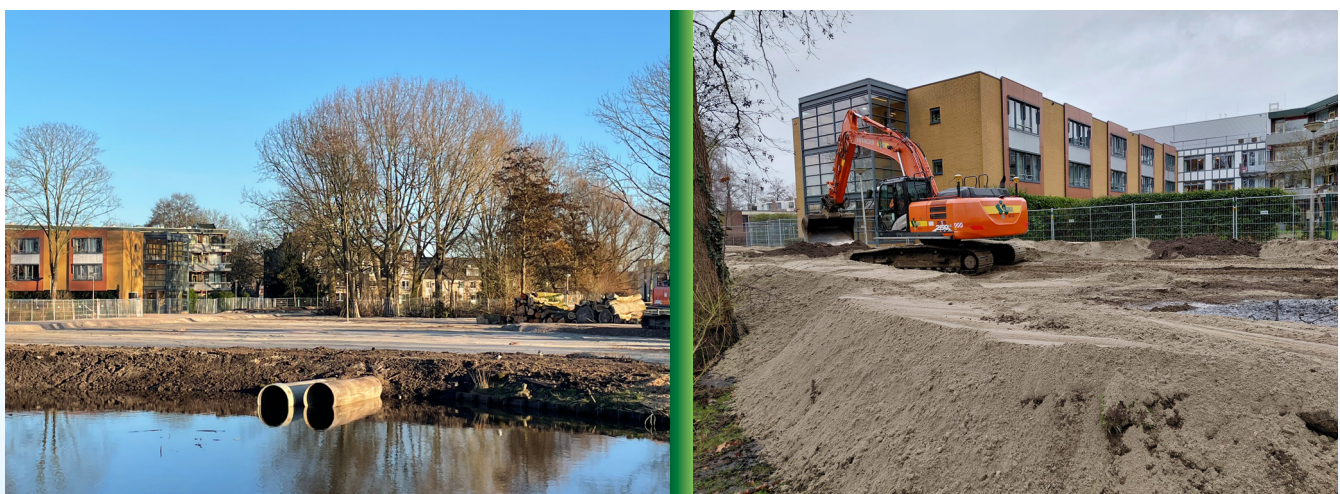
Afbeelding 1 en 2 werkzaamheden voor het bouwrijp maken
